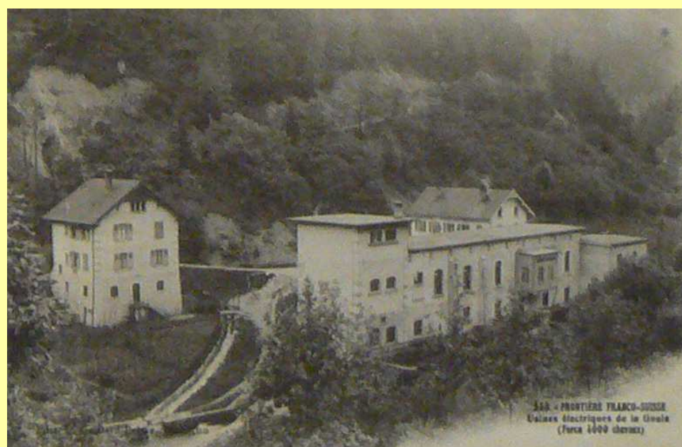
Frontière Franco-Suisse - Usine électrique de la Goule (force 7,5 Mw)
