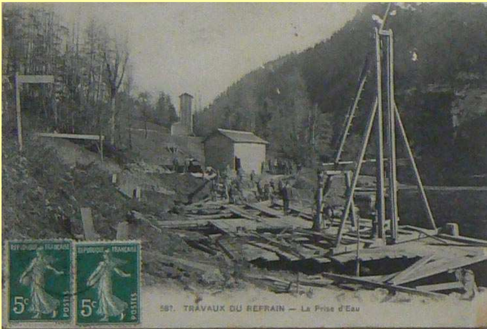
Travaux du Refrain La prise d'eau
