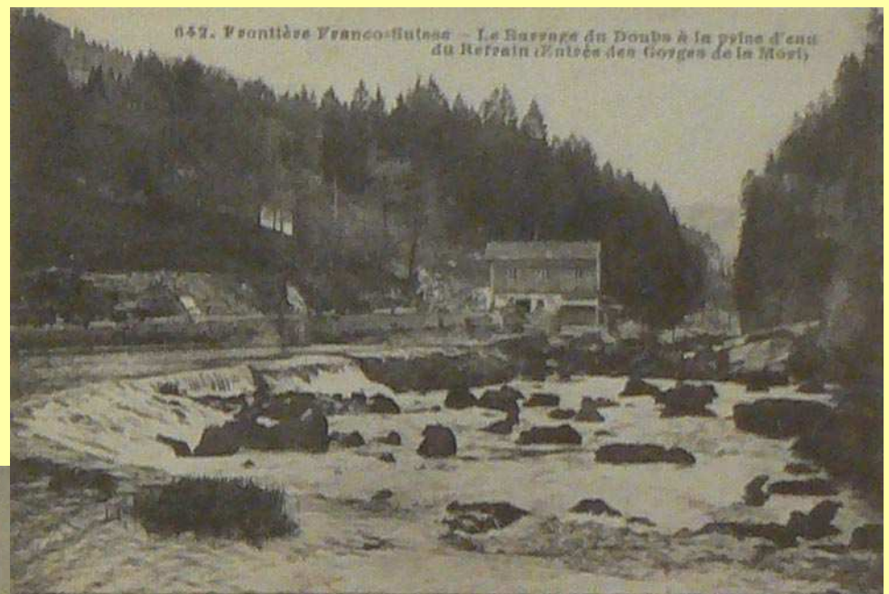
Frontière Franco-Suisse - Le Barrage du Doubs à la prise d'eau du Refrain (entrée des Gorges de la Mort)
