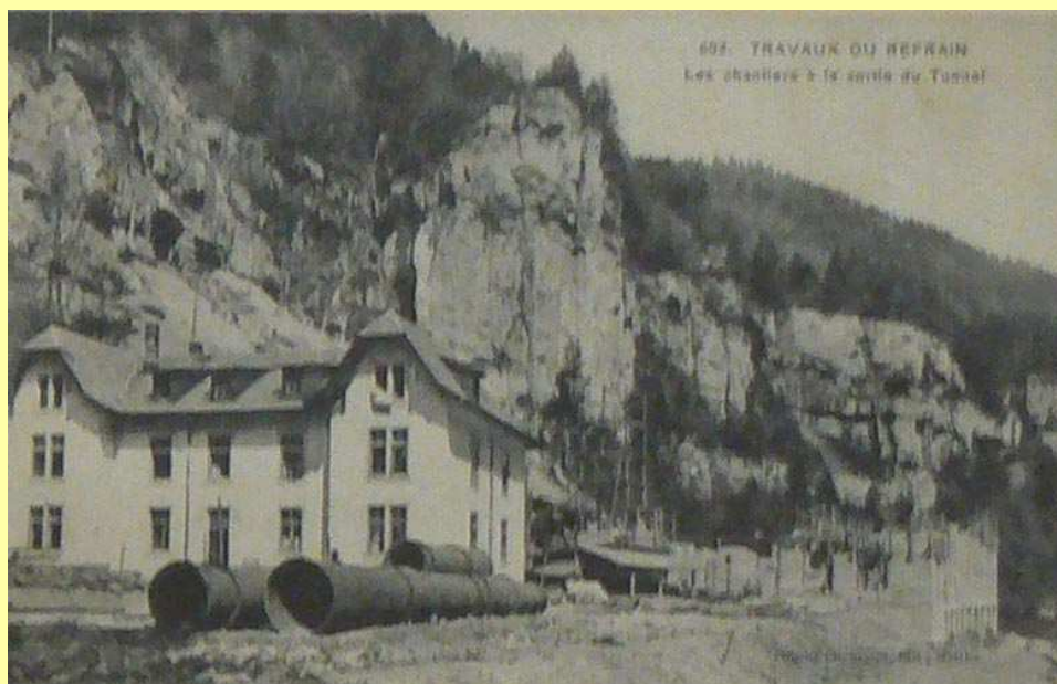
Travaux du Refrain - Les chantiers à la sortie du tunnel
