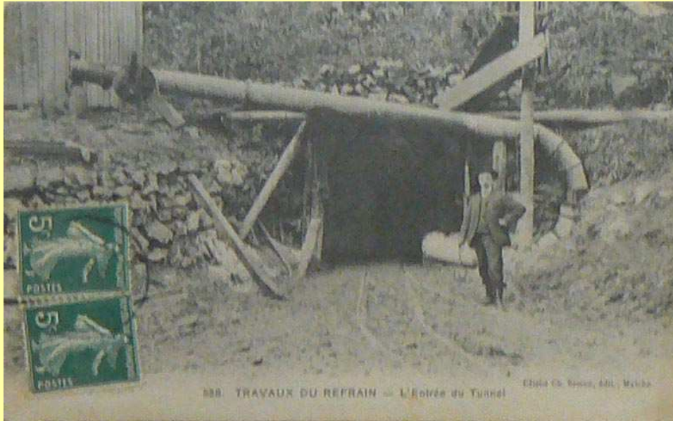
Travaux du Refrain Entrée du tunnel
